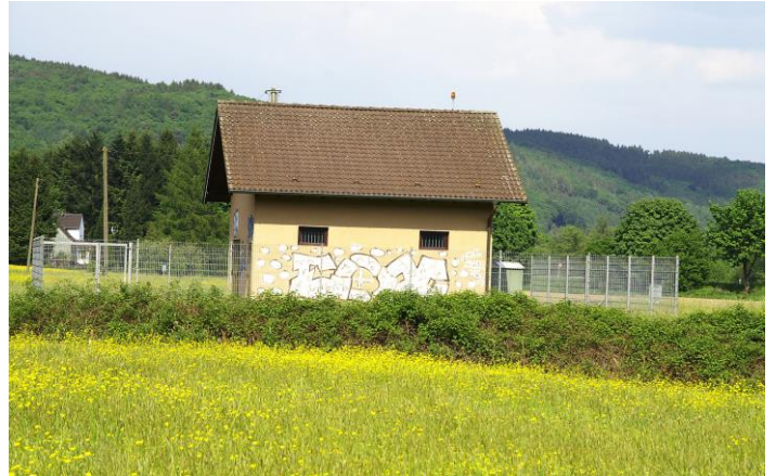
Das im Jahre 1996 neu erstellte Pumpenhaus
